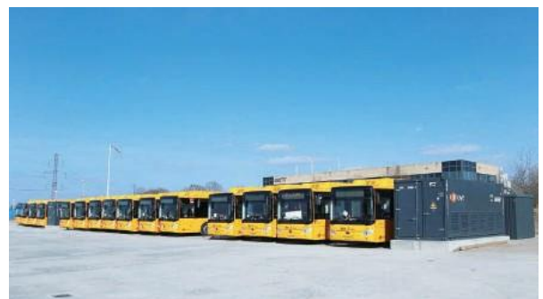
Erste dänische EV Bus-Ladestation in Roskilde, DK
